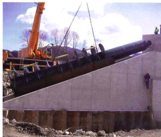
BEA Electric wurde mit Lieferung, Montage und Inbetriebnahme der Schnecke beauftragt, die mittlerweile den ersten Strom erzeugt hat.
